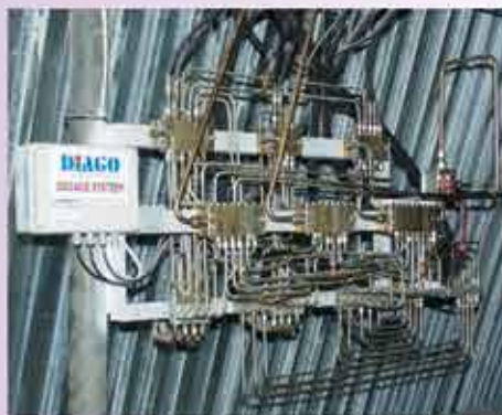
Mazací systém pro mazání jeřábových drah
