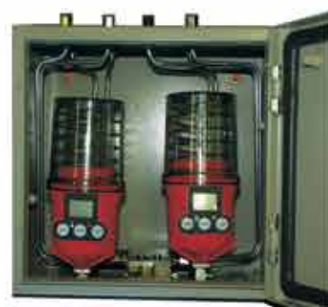
Mazací systém s pístovými pumpami
