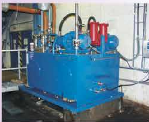
Oběhový olejový centrální mazací systém
